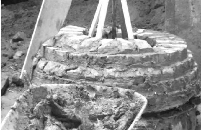
weiteren Konstruktionen benötigt. Auf diesen Ziegelkern wird zuerst eine grobe Lehmschicht aufgebracht, die mit immer feiner werdenden Schichten
