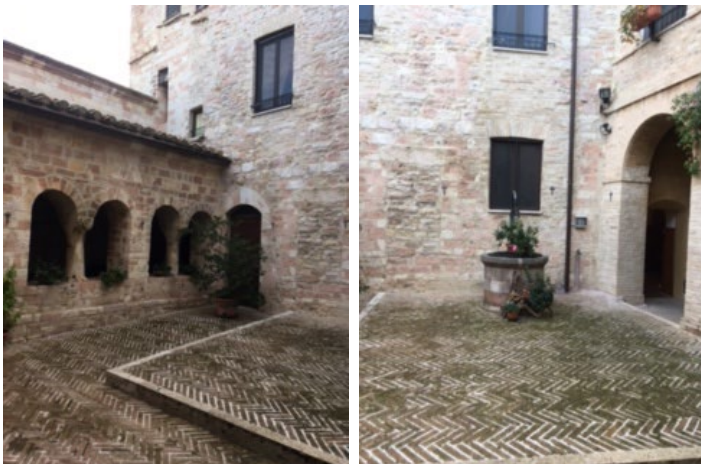
Der Innenhof des Hauses der Schwestern
